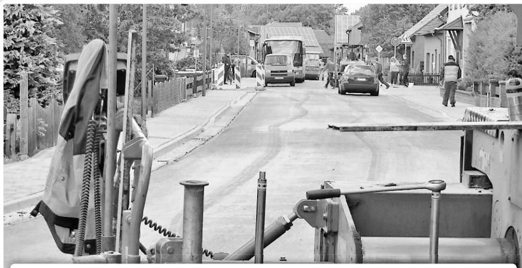
Ortsdurchfahrt Bergfeld: Am Dienstag wurde die Straße asphaltiert. Nach Pfingsten soll sie für den Durchgangsverkehr wieder freigegeben werden. Photowerk (jr 2)
